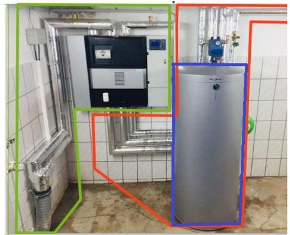
**Einmalige Umbaukosten** (rot umrandet) sind für den Anschluss ans Hausnetz notwendig, • das Ausdehnungsgefäß, • Pumpen/Mischer und • evtl. einen Warmwasserspeicher für Trinkwasser.
