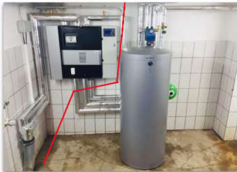
Foto: PEWO Wärmeübergabestation - Typ: eco
